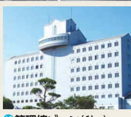
12 管理棟ゾーン (6ha) 管理研修棟、宿泊棟、厚生施設などがあります。
